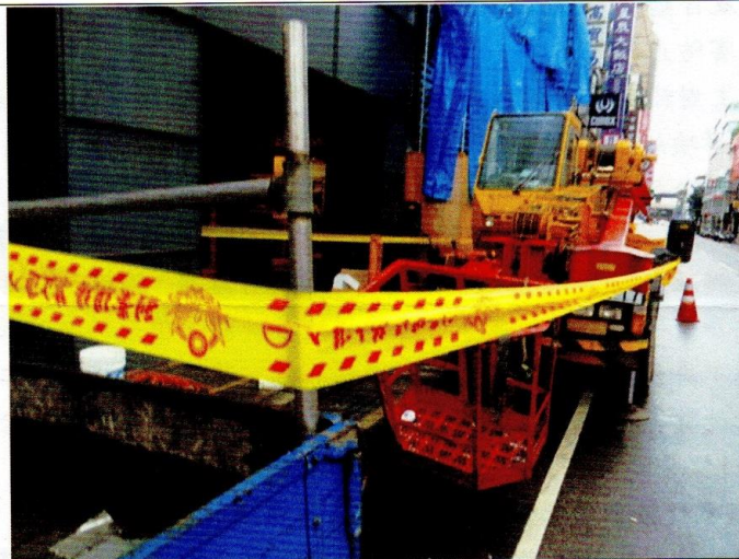
照片說明：移動式起重機及搭乘設備
